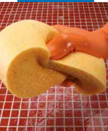
Намокряне на повърхността на фугите преди почистване
