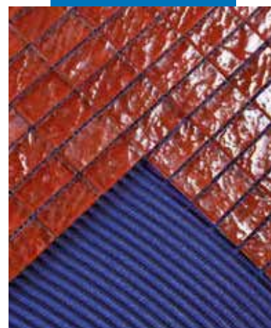
На следващия ден - фугиране с Керароу Design със същия цвят и по същия начин показан по-горе
