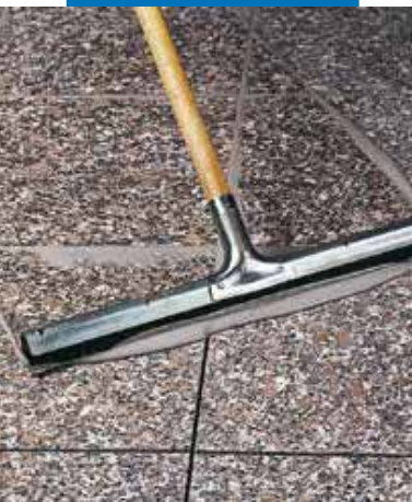
Фугиране на предварително шлифован и полиран гранит за под
