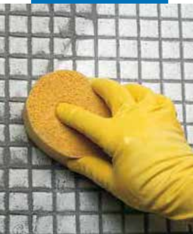
Крайно обработване на стъклени плочки с гъба
